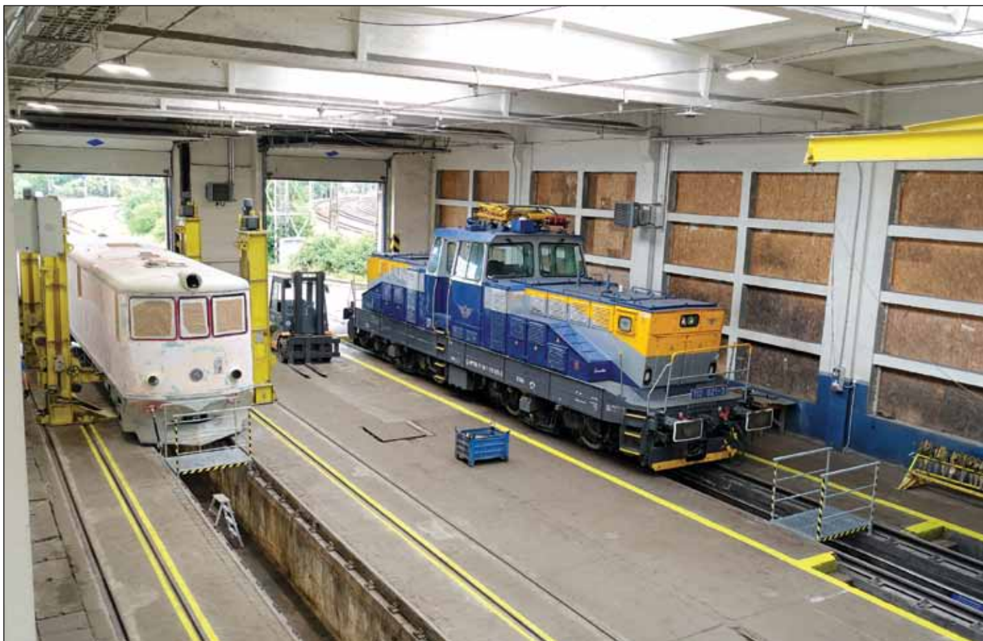
Pohled z června 2022 do znovuzrozené haly někdejšího depa v Kutné Hoře, dnes užívané společností WYNX Pool, s. r. o., zachycuje kromě jedině v České republice provozované „žehličky“ řady 110, stroje 110.021, také pro České dráhy opravovaný a modernizovaný úzkorozchodný stroj 705.914 z trati Třebešná – Osoblaha.
